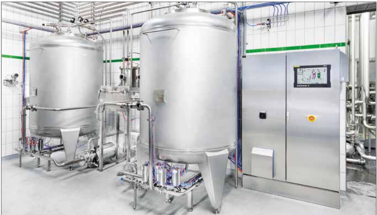
CONTI FLASH Kurzzeiterhitzungsanlage mit einer Leistung von 50 hl/h
